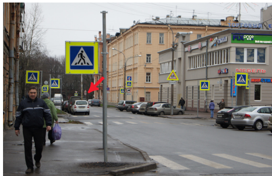
Одно из знакомых местечек Кронштадта. Обратите внимание на штырь, торчащий из знака «Пешеходный переход» на переднем плане. Эта железная длиной сантиметров 60 заканчивается примерно на уровне 130 см от земли.
