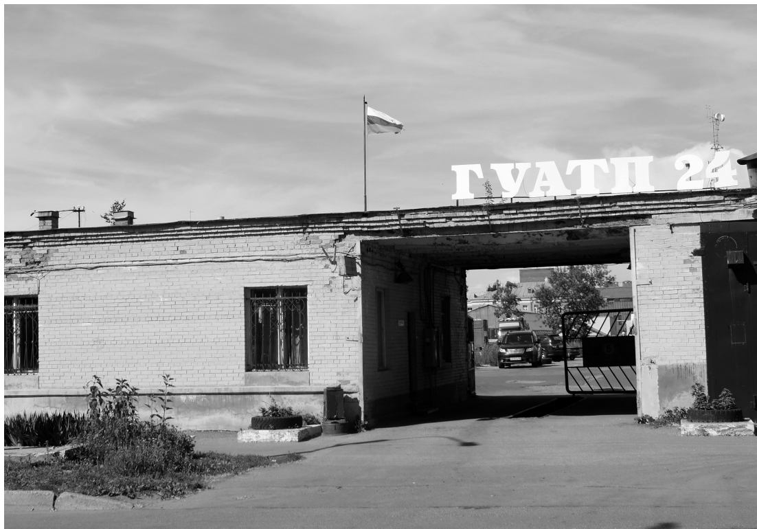
На этом месте будет построен жилой дом. Но не один большой, а несколько маленьких, соединенных между собой арками.
