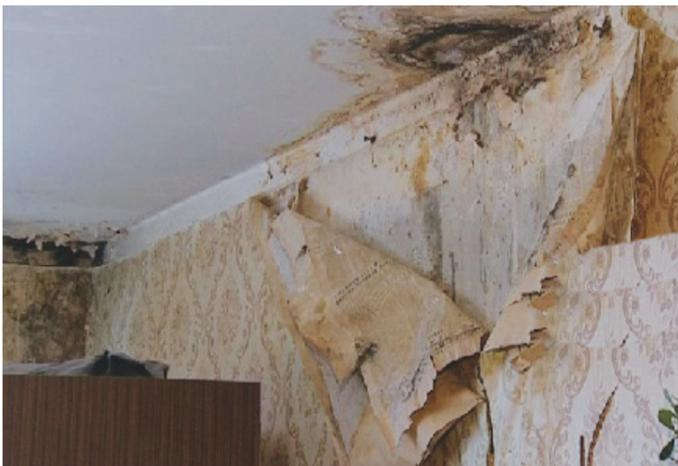
Так, летом 2012 года жильцы дома по Инге, 2 уехали в отпуск, оставив подключенной стиральную машину. В отсутствие владельцев из машины вырвало шланг и залило соседей снизу. Плюс пострадали соседи сверху, вплоть до самого верхнего этажа. Потому что коммунальные
